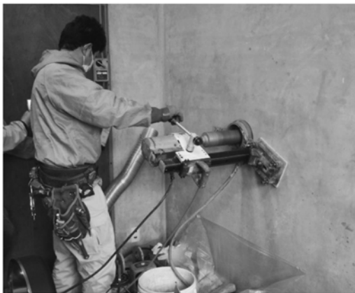
図 1 コンクリート壁面のコアボーリング
